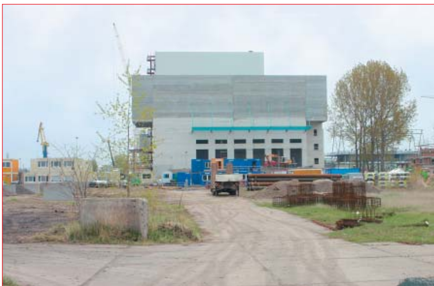
Müllheizkraftwerk (MHKW) in Rothensee engt stoffliche Grundlage der Recyclingwirtschaft in Magdeburg deutlich ein.
