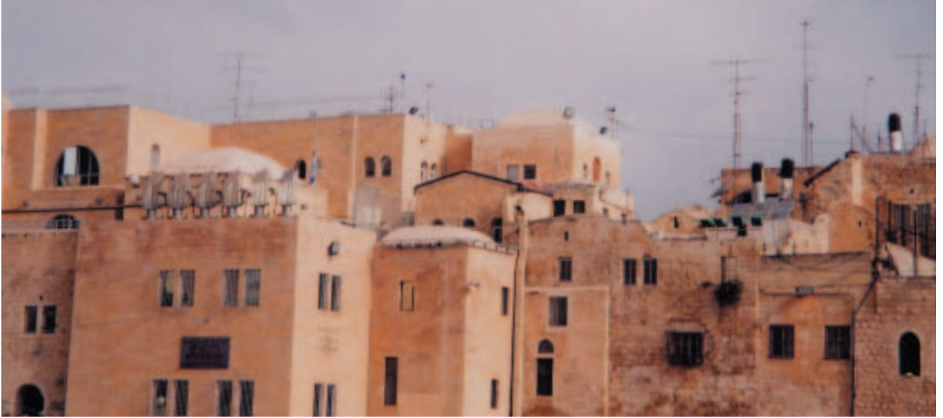
Jerusalem Altstadt, Bebauung nahe der „Klagemauer“.
